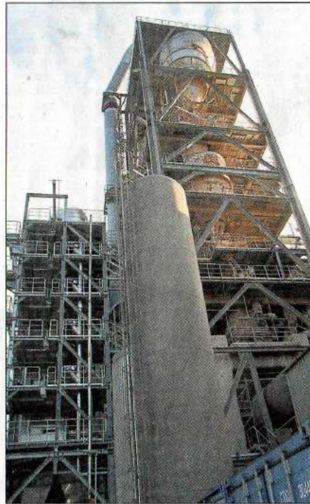
Wahrzeichen: Der Wärmetauscherturm der Phoenix Zementwerke ist schon von Weitem zu sehen. Direkt daneben baut das Unternehmen einen Katalysator.
