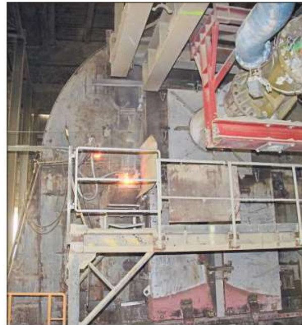
Mehr als nur muckelig warm war es im Ofen-Bereich des Holcim-Werks in Beckum.
